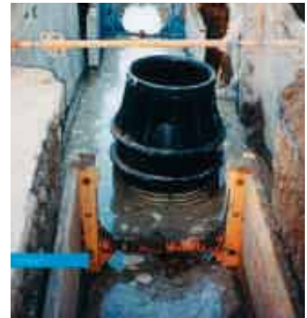
Komplizierter Einbau mit Freispiegelkanalisation mit Spundwänden und überflutetem Graben
