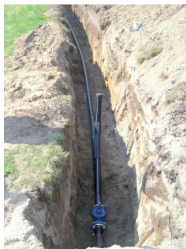
Flache und schmale Gräben zur Rohrleitungsverlegung in PE-HD oder PVC (d90–d250).
